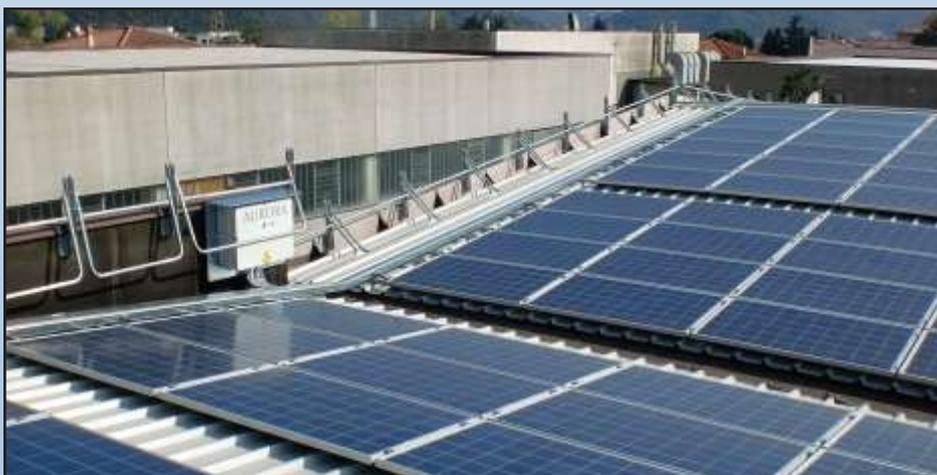
Parapetto permanente per la messa in sicurezza di superfici piane o leggermente inclinate e si installa mediante tassellatura.
