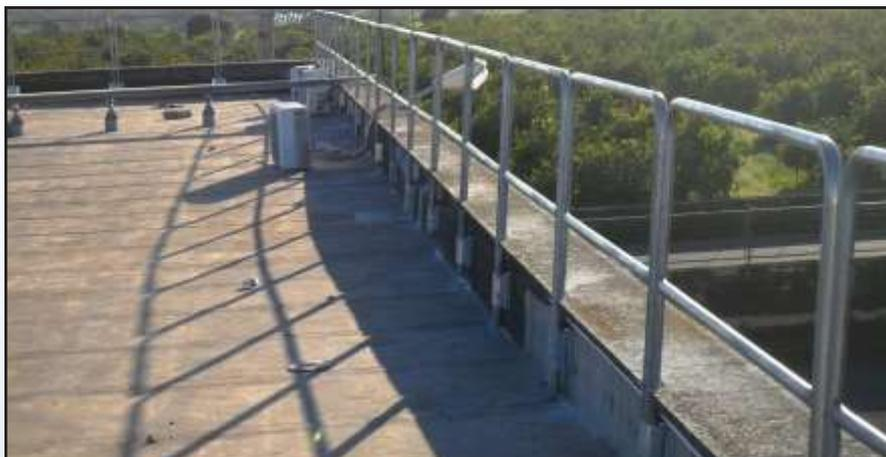
Protezione permanente per tetti e superfici piane, fissata verticalmente mediante tassellatura della piastra di fissaggio. Questo dispositivo di protezione collettiva consente di mettere definitivamente in sicurezza, in maniera **pratica ed economica**, le superfici di lavoro.
